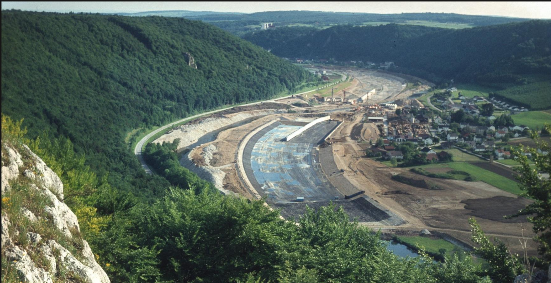
Der Main-Donau-Kanal im Bau (Aufnahme des Betriebs 1992)
