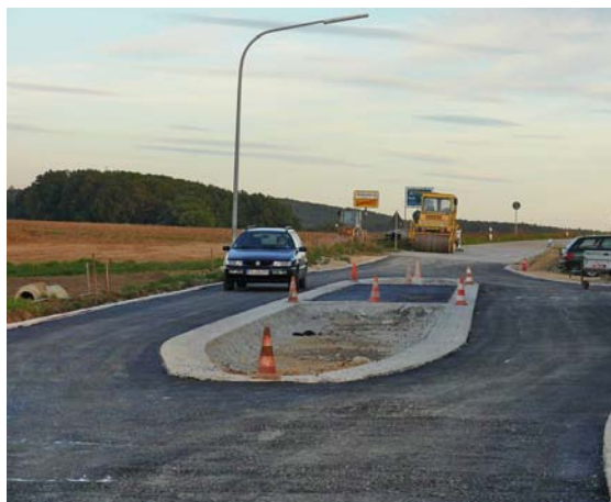
Verkehrsinsel am Ortseingang Viehhausener Straße im Bau
