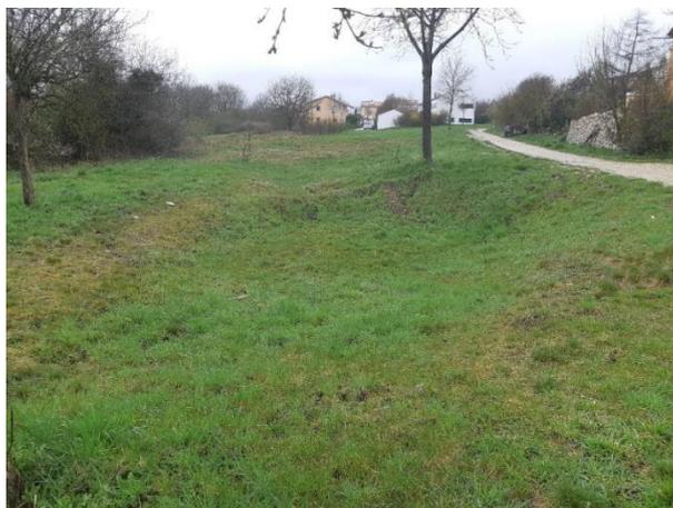
Abbildung 1: Versickerungsbecken 1 mit Überlaufschwelle in Versickerungsbecken 2, (12.04.2023)
