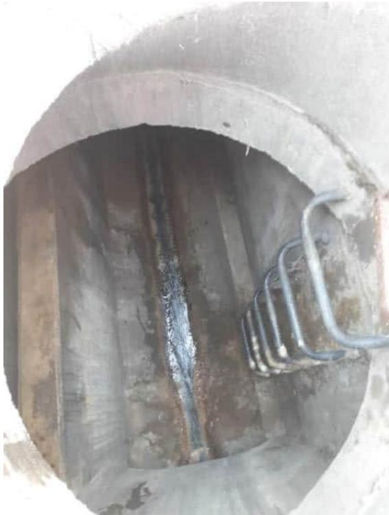
Abbildung 4: Stauraumkanal Badanhausen mit Überlauf
