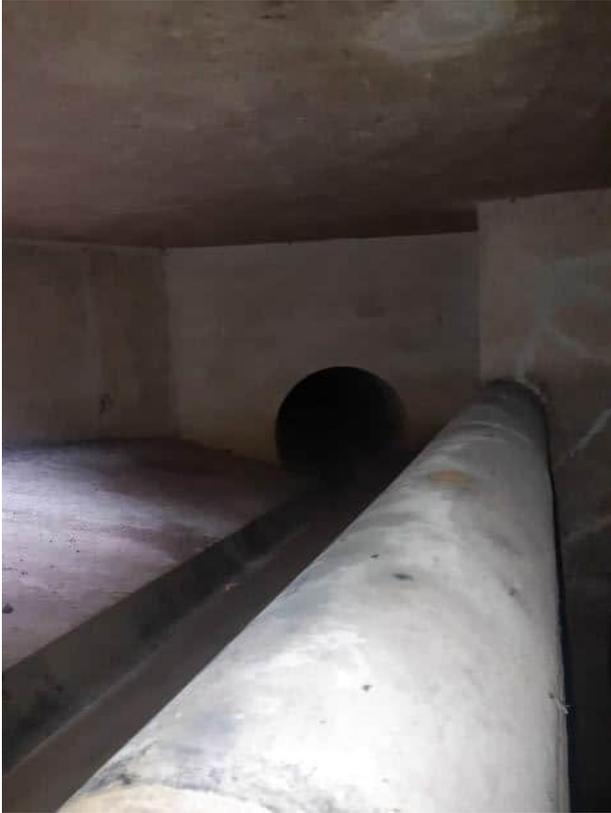
Abbildung 1: Überfallschwelle und Zulauf zum Stauraumkanal
