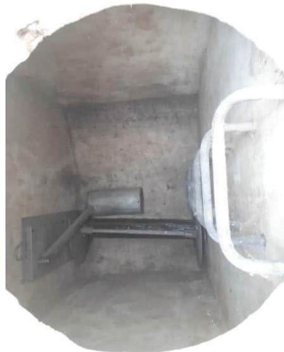
Abbildung 5: Hydroslide Stauraumkanal Badanhausen
